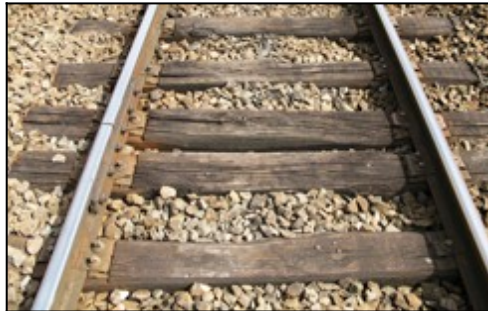
Rails courts sur traverses bois
